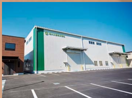
新設の美原工場は、本社工場とほぼ同じレイアウトで設計。新事業も見据えて、1ライン増設されている。
