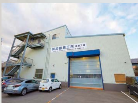
10tトラックで重量のある製品を搬出できるようになった新美原工場
