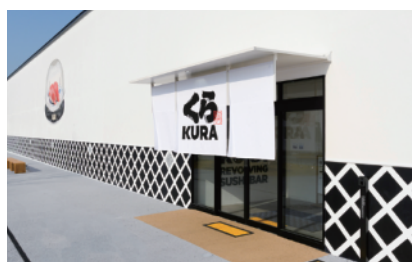
外壁材には廃棄される貝殻を再利用
